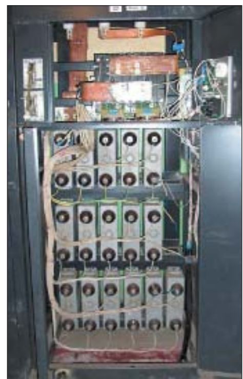
Рис. 6. Вид на монтаж шкафа ячейки компенсатора
