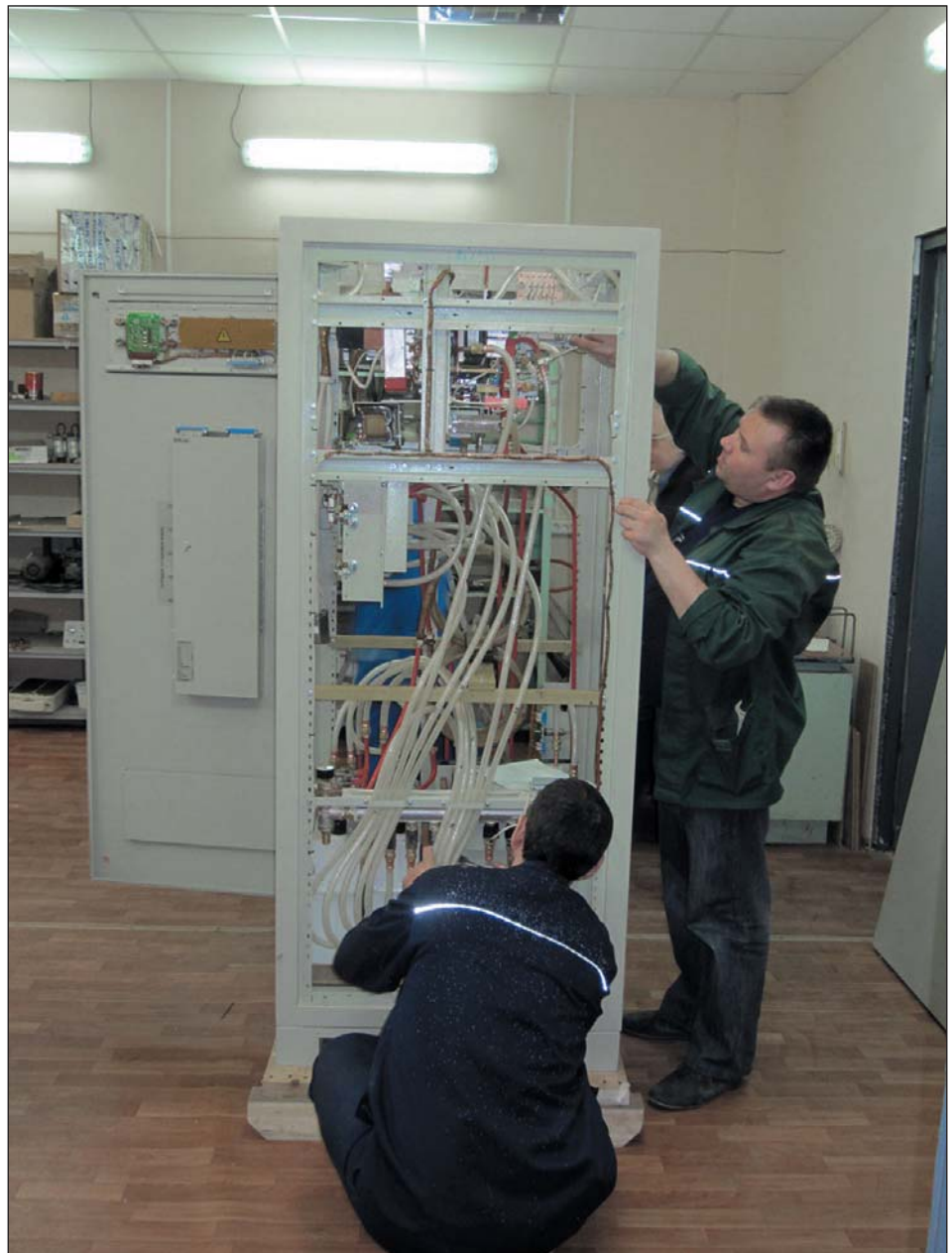
Рис. 6. Монтаж системы охлаждения преобразователя частоты
