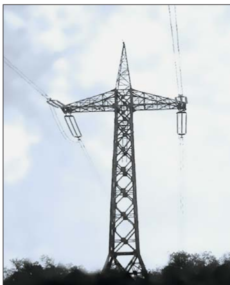
Рис. 7. Опора HVDC ЛЭП Донбасс–Волгоград
