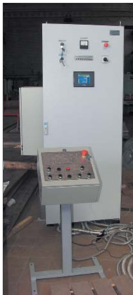
Рис. 8. Наладочные работы МТМ-1000К1 на авиационном заводе
