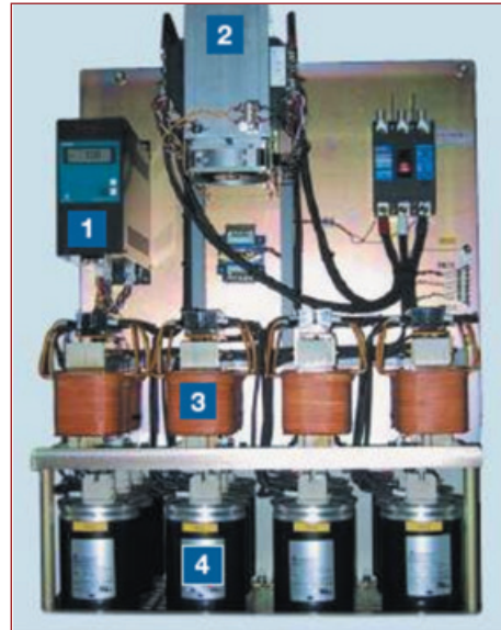
Рис. 3. Пример расположения компонентов фильтрокомпенсирующих звеньев КУ: 1 — регулятор РМ; 2 — вентилятор; 3 — защитные дроссели; 4 — КБ PhaseCap
